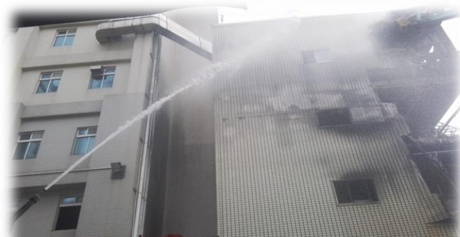
拆除作業期間持續加壓噴水
