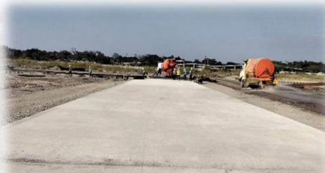
完整鋪設PC路面
