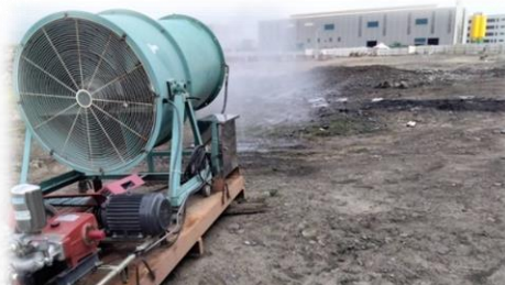
設置灑水設備
