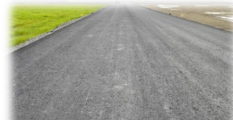
完整鋪設AC路面
