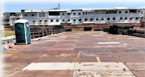
完整鋪設覆工板
